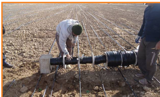
شکل ۵- (الف) دستگاه مکانیزه نصب لوله‌های آبیاری تیپ در مزرعه و (ب) نصب دستی لوله تیپ از طریق قراردادن کلاف‌ها بر روی قرقره و جابجایی آن‌ها
