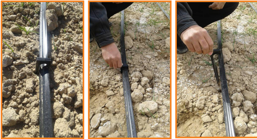
شکل ۱۰- استفاده از بست پلاستیکی برای مهار لوله تیپ در مقابل بادبردگی
