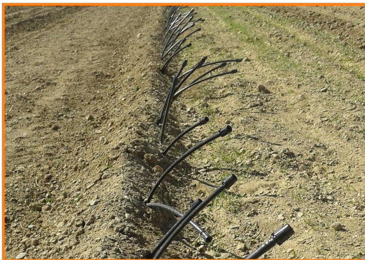
شکل ۲- خروج لوله‌های ۱۶ میلیمتری ابتدای مزرعه از زیر خاک و آماده برای اتصال به نوارهای تیپ
